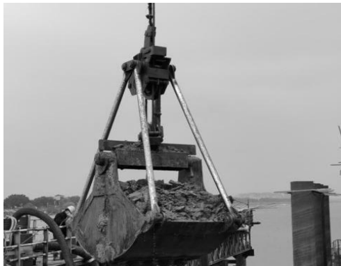
图 4-5 抓斗开挖施工图
