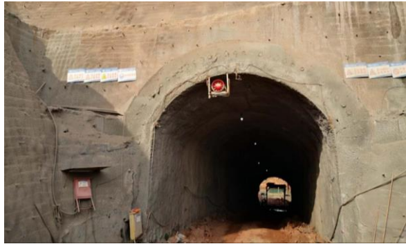
图4 综合管廊浅埋暗挖施工现场照片
