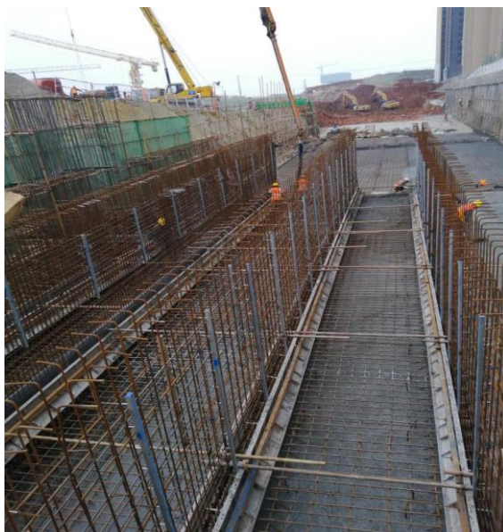
图3 综合管廊明挖现浇法施工现场照片
