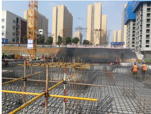
图1 建筑施工现场
