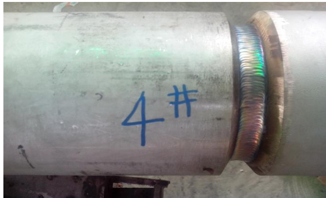
图1 焊接接头为 V 型坡口，氩弧焊打底
