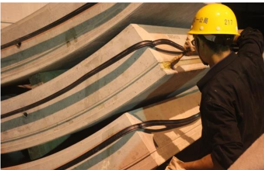
图 6：管片涂刷胶粘剂图
