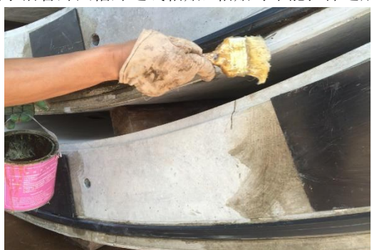
图 10: 挡水条凹槽涂刷胶粘剂图
