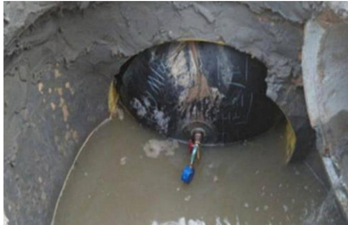
图1 管道闭水试验
