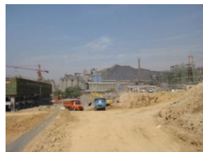
图4 桩基施工现场
