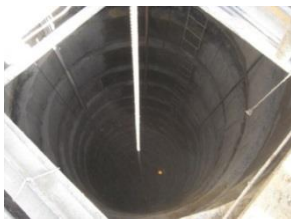
图3 施工中的人工挖孔桩
