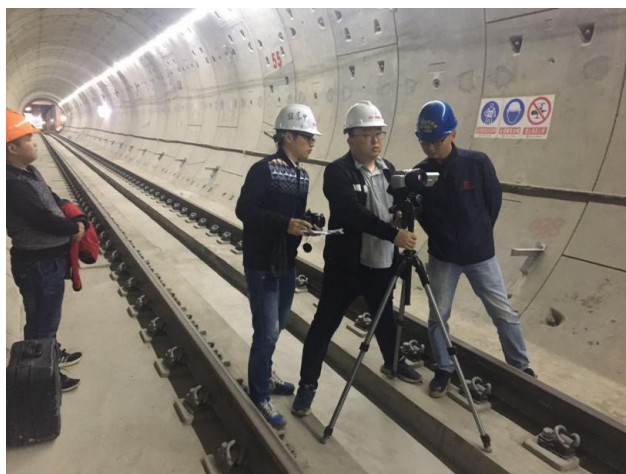
图2 第三方隧道贯通测量
