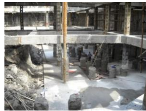
图 5 立柱桩现场影像
