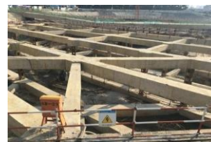
图 8 立柱桩现场影像
