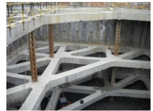
图 6 立柱桩现场影像
