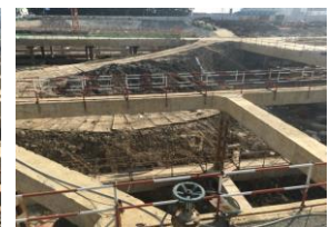
图 9 立柱桩现场影像
