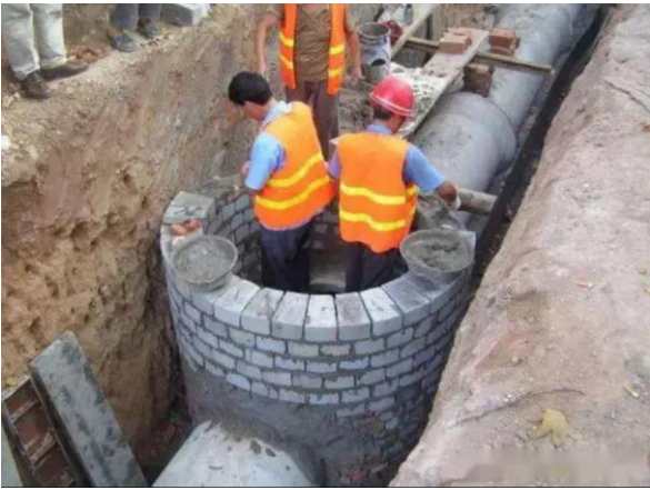
图2 检查井砌筑作业
