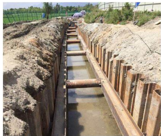
图 1 沟槽开挖支护施工示意图
