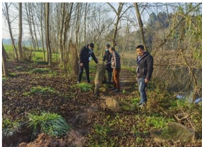
图1 土地整治监管施工
