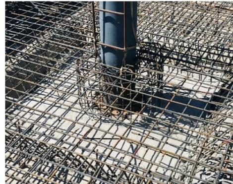
图 5 柱脚实际工程节点大样图
