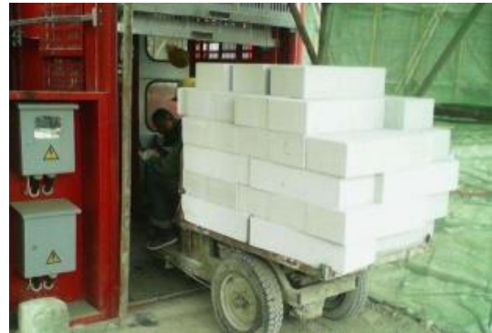
图7 电动三轮车运输加气混凝土砌块
