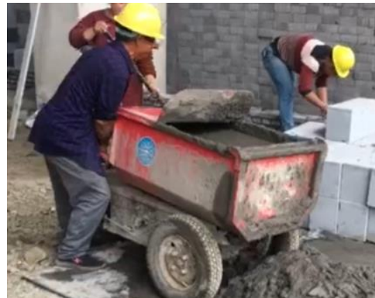
图6 电动灰斗车运输砌筑砂浆
