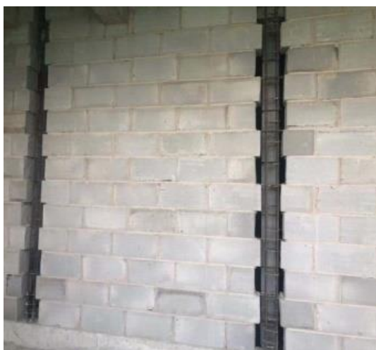
图10 填充墙体砌筑局部施工效果
