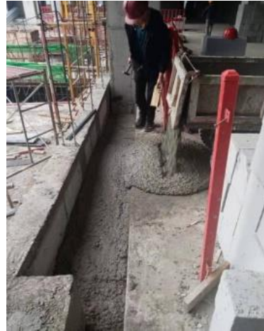
图5 电动手推车运输混凝土
