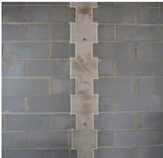
图9 构造柱混凝土浇筑
