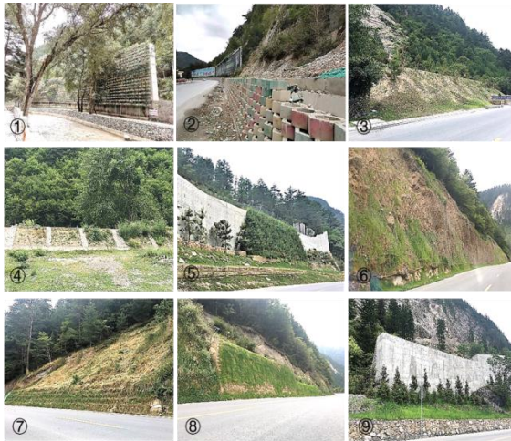
图1 现有边坡生态修复情况
