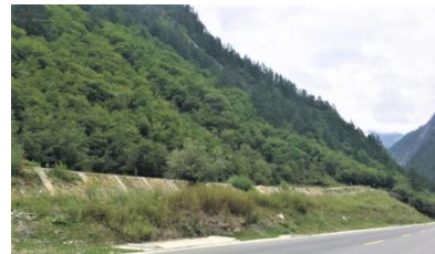
图 4 荷叶寨下行 0.3km 已修复边坡
