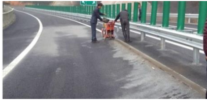
图4 沿标线纵向水迹带切割开槽
