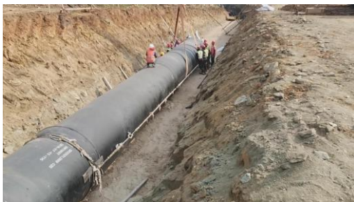
图5 管道安装连接
