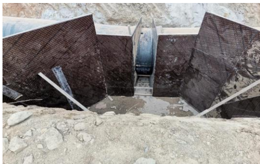
图1 T型管道弯头处支墩
