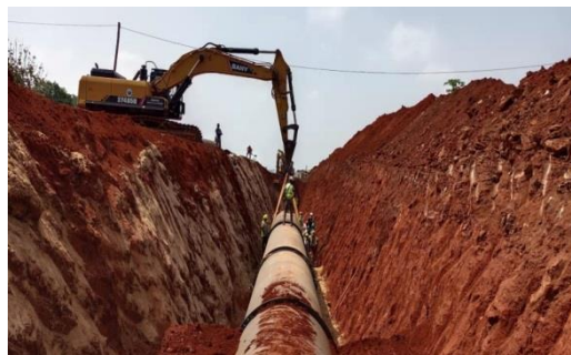
图2 485 挖机吊装管道
