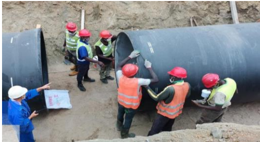
图4 打磨清洗承插口
