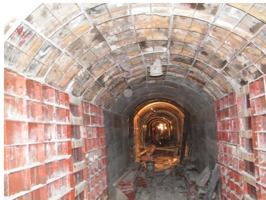
图1 水库导流洞开挖施工图
