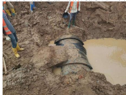
图8 管道漏水
