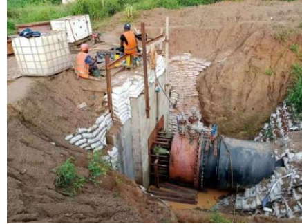
图7 管道注水打压
