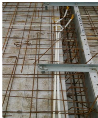
图15 现场铝模吊模、反坎安装示意图
