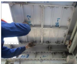
图11 楼面模板安装模板收口
