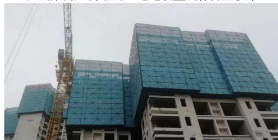
图 29 附着式升降脚手架立面图
