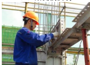
图5 梁侧铝模安装示意图
