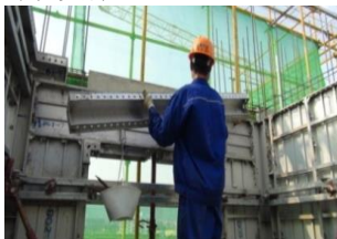
图7 墙梁铝模连接示意图
