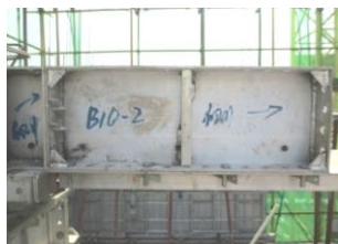
图6 梁侧铝模安装示意图
