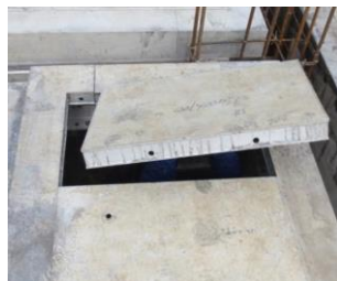
图12 楼面模板安装模板收口
