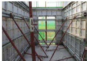
图8 墙梁铝模支撑示意图
