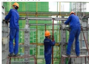
图4 梁底铝模安装示意图
