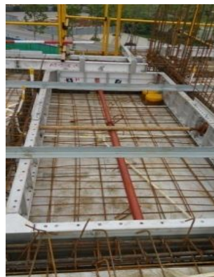
图16 现场铝模吊模、反坎安装示意图
