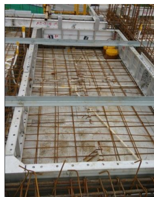
图14 现场铝模吊模、反坎安装示意图
