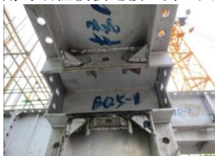
图3 梁底与墙柱模板节点
