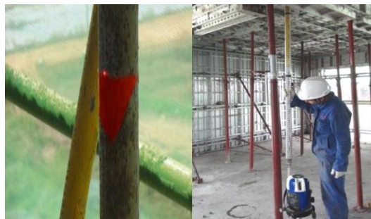
图13 模板现场标高调整
