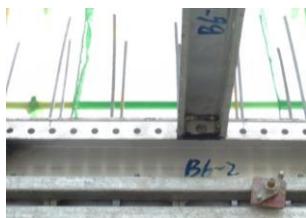
图10 楼面底笼安装底笼与C槽节点
