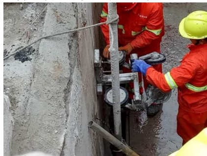
图 3 安装导向滑轮
