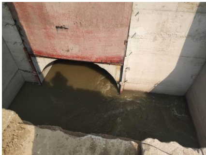
图11 封堵完成后污水改流至超越管
