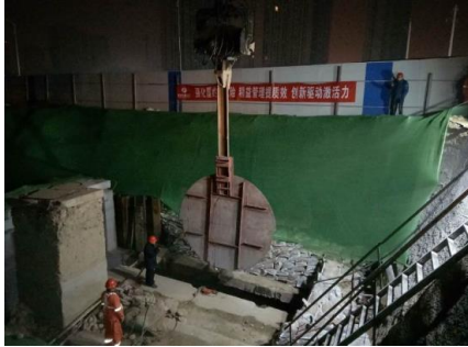
图9 安装钢挡板
