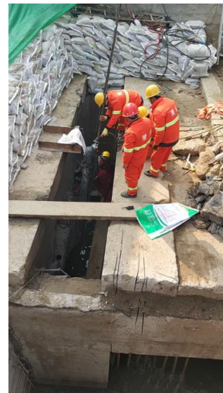
图8 气囊进入管道，连接固定装置
