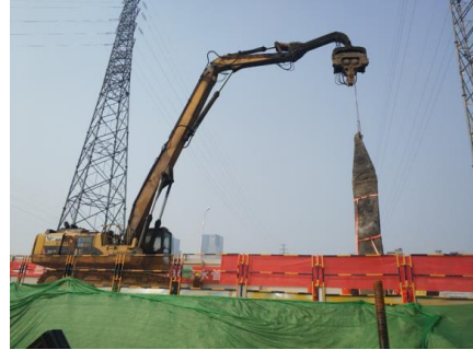
图7 气囊吊装
