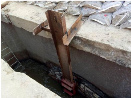
图10 钢挡板固定
