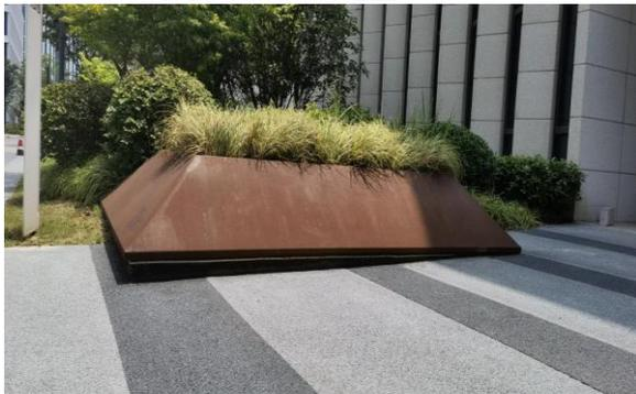
图2 耐候钢材料景墙的功能性和装饰性示例
