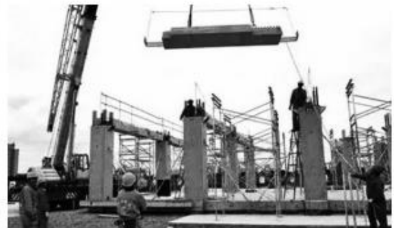
图2 装配式构件安装施工
