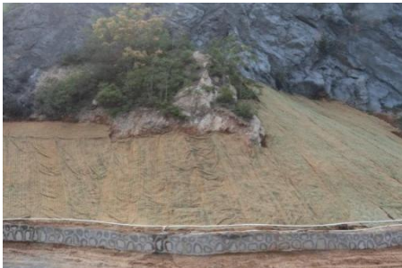
图9 陕西某矿山植生草毯施工后照片
