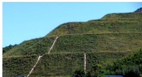
图12 某高陡边坡台阶治理照片
