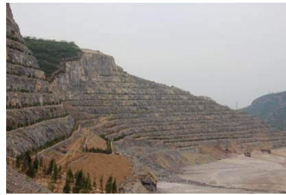
图11 河北省某高陡边坡坡率法治理照片
