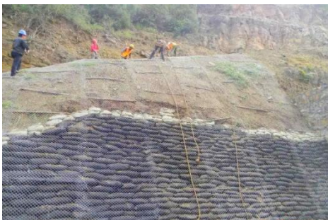
图10 陕西某矿山植生袋施工现场
