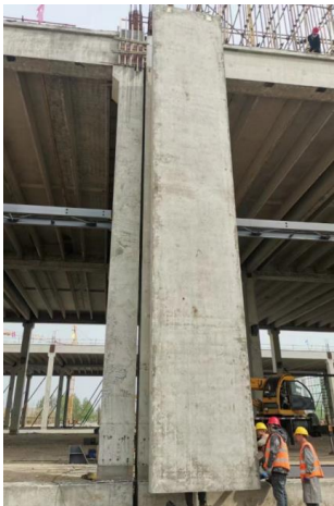
图9 外墙板安装
