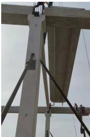
图8 双T板安装
