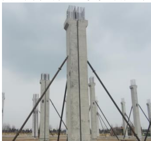
图6 预制柱安装
