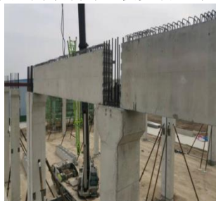
图7 预制叠合梁安装
