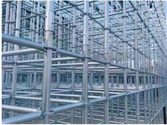
图1 某工程盘扣式脚手架装设示意图
