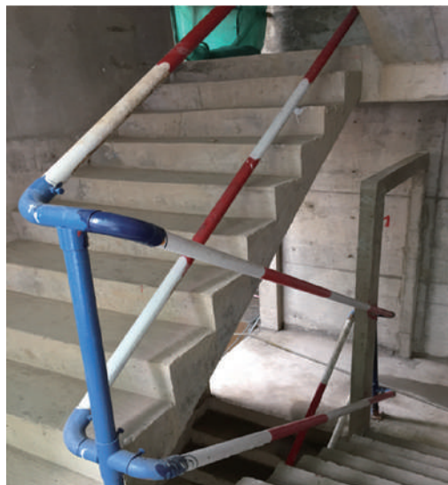
图 6 工具式楼梯临边防护栏杆
