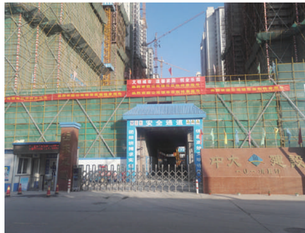
图2 定型化钢构柱伸缩式大门体系
