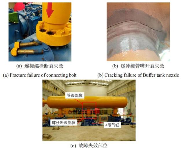
图1 案例项目压缩机管道装置故障图
