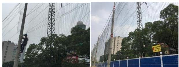
图 4 水平限界高压警示钢丝网现场安装
