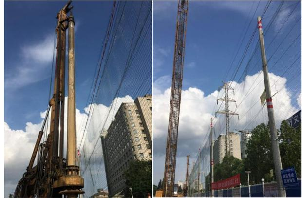
(a) 旋挖钻机成孔 (b) 钢筋笼整体吊装
