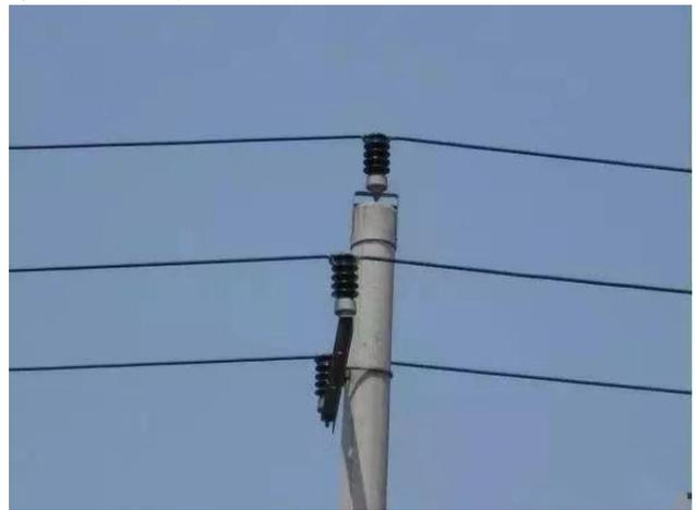
图 3 单回路单柱式绝缘子三角排列杆
