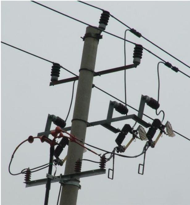
图 1 10kV 避雷器
