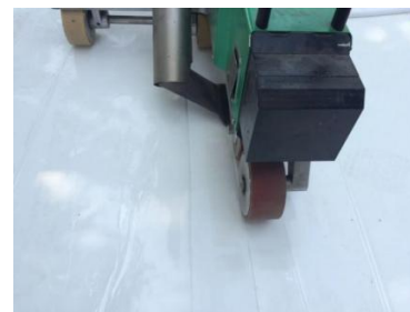
图9 防水卷材焊接
