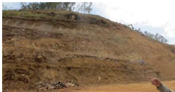
K9+730~K9+850 段开挖现状
