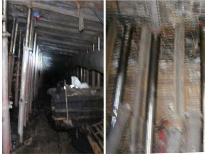
图 4 011810 工作面胶运顺槽 110 工法留巷后现场效果图
