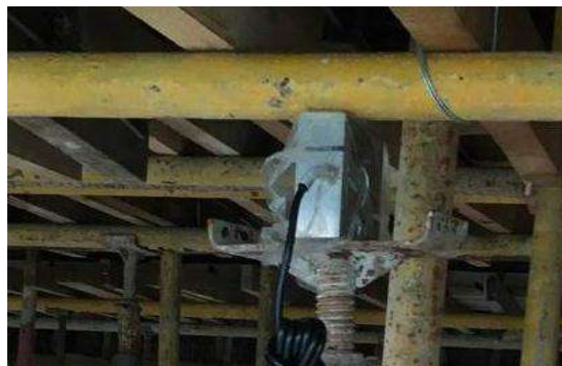
图 7: 立杆轴力传感器安装图
