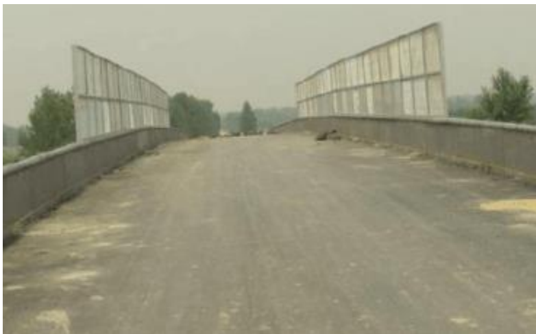
图1 纤维复合材料桥面体系
