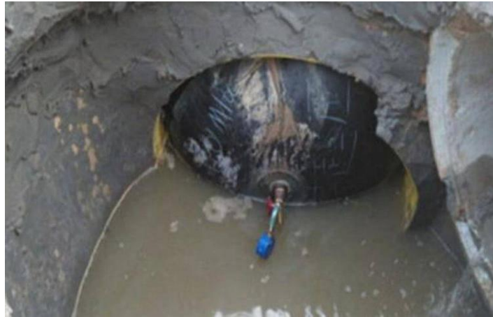
图1 管道闭水试验
