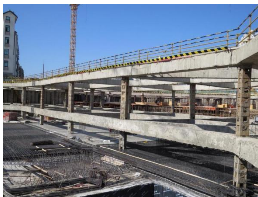
图 4 竖向支撑工况图
