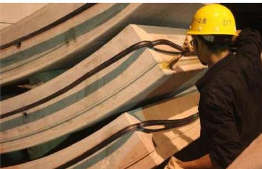
图 6：管片涂刷胶粘剂图
