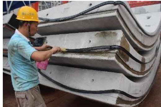
图 7：粘贴材料涂刷胶粘剂图
