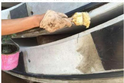
图 10: 挡水条凹槽涂刷胶粘剂图
