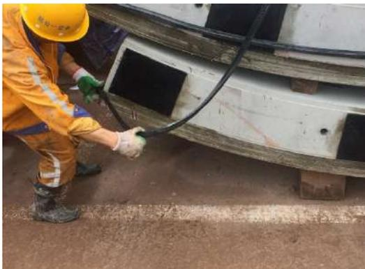
图 8: 弹性橡胶密封垫安装图
