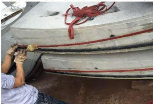
图 11: 挡水条安装图
