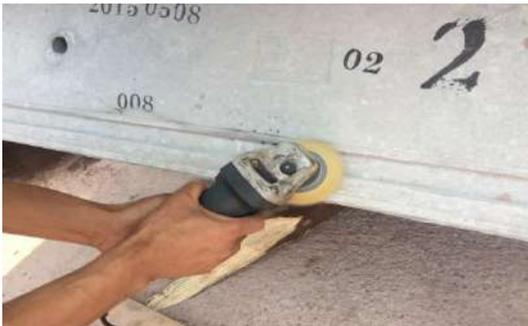
图 4：打磨除尘图
