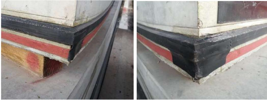
图 14: 角部自粘性橡胶薄板安装图
