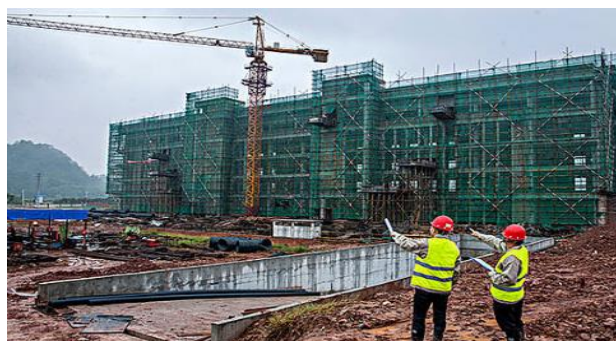
图1 施工现场进度管控
