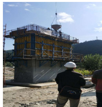
图9 第二次浇筑混凝土
