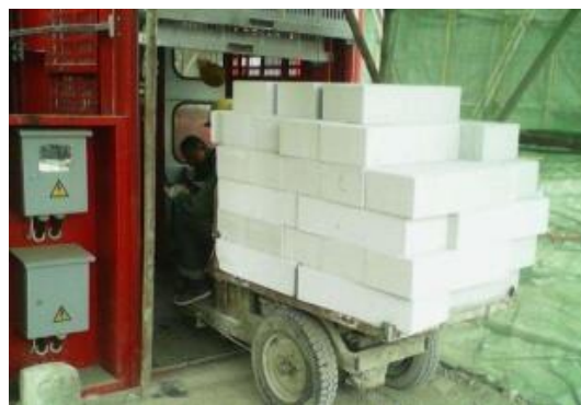
图7 电动三轮车运输加气混凝土砌块
