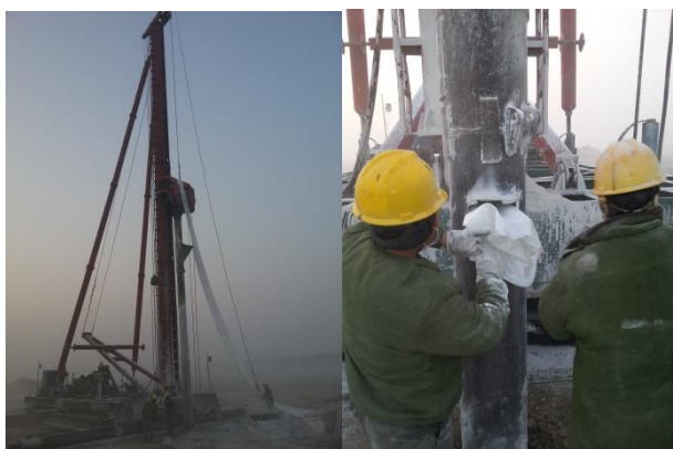
图1 土工布袋施工
