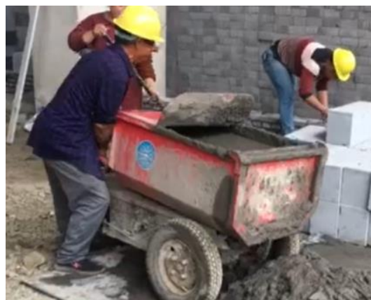
图6 电动灰斗车运输砌筑砂浆
