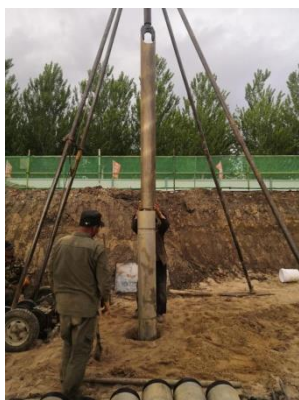
图4 插入导向管
