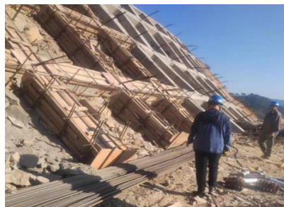
图5 格构梁模板安装
