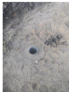
图6 滤管安装完成
