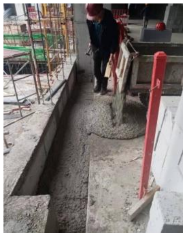
图5 电动手推车运输混凝土
