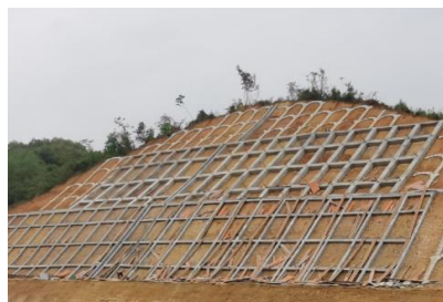
图6 格构梁浇筑成型
