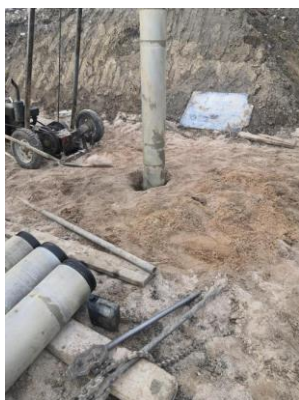
图3 固定导向管
