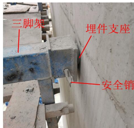
图8 支架安装现场图
