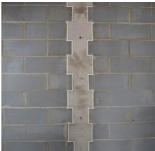
图9 构造柱混凝土浇筑
