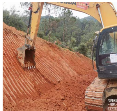
图 4 边坡刷坡成型
