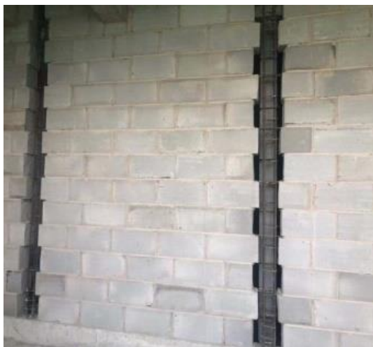
图10 填充墙砌体砌筑局部施工效果
