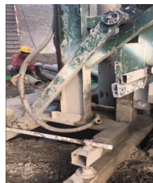
图6 换浆法清孔
