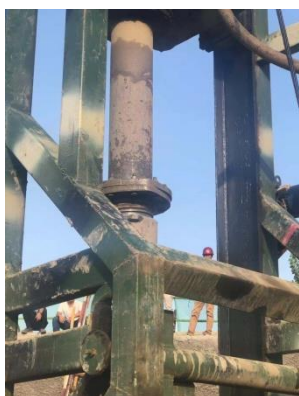
图8 钻机导管安装
