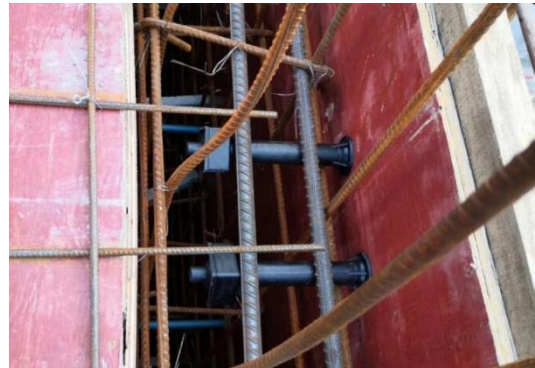
图8 预埋螺栓现场图
