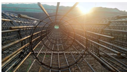
图3 钢筋笼焊接完成
