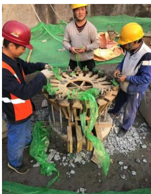
图4 单桩竖向静载荷试桩试验
