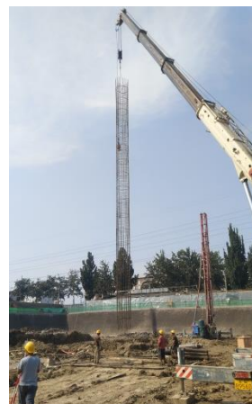
图7 汽车吊吊放钢筋笼
