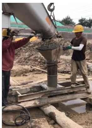
图9 拆除导管
