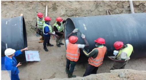
图4 打磨清洗承插口
