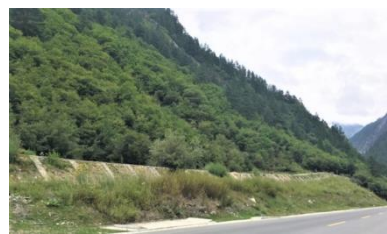
图 4 荷叶寨下行 0.3km 已修复边坡
