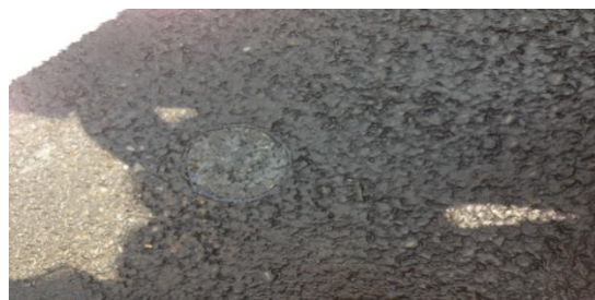
图8 沥青麻絮封闭
