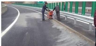
图4 沿标线纵向水迹带切割开槽
