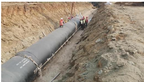
图5 管道安装连接
