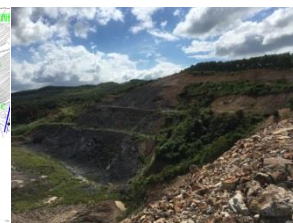
图2 西坡现场图片
