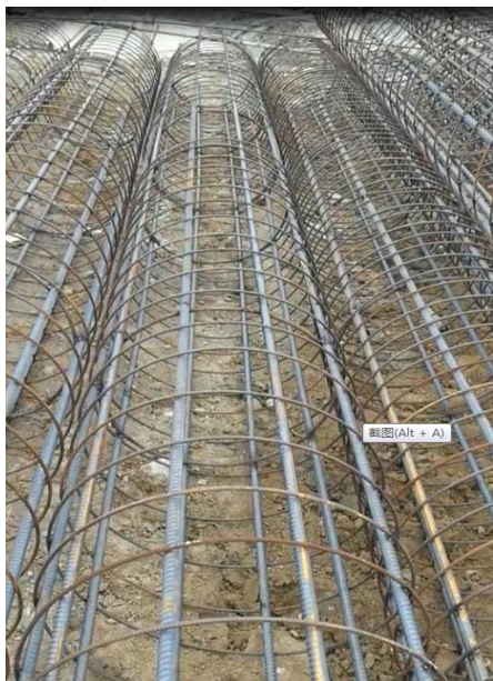
图3 制作完成的钢筋笼
