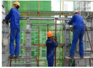
图4 梁底铝模安装示意图
