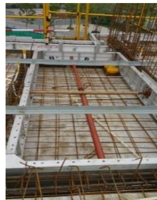
图16 现场铝模吊模、反坎安装示意图
