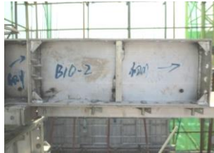
图6 梁侧铝模安装示意图
