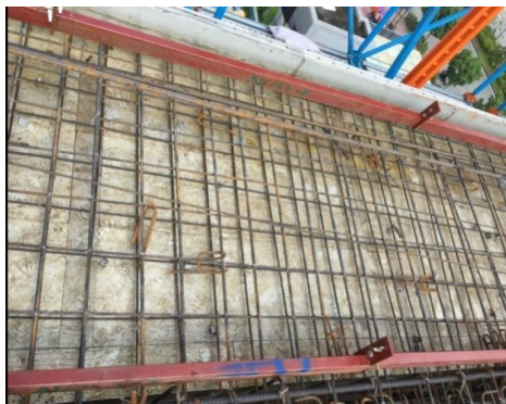
图 17 现场铝模吊模、反坎安装示意图
