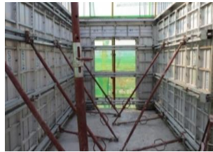
图8 墙梁铝模支撑示意图
