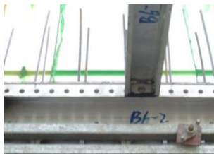
图10 楼面底笼安装底笼与C槽节点
