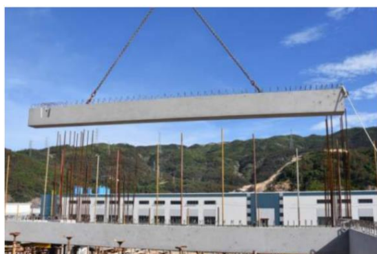
图 26 叠合梁吊装示意图
