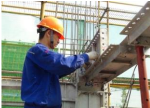
图5 梁侧铝模安装示意图
