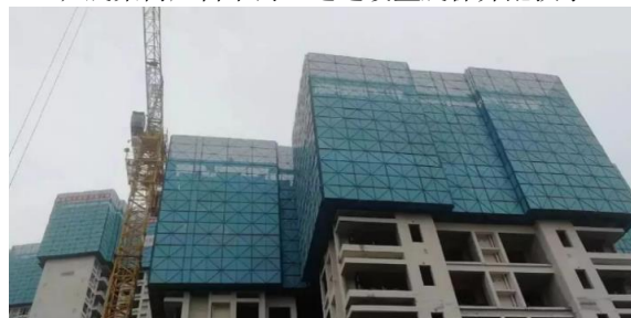
图 29 附着式升降脚手架立面图
