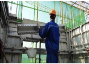
图7 墙梁铝模连接示意图
