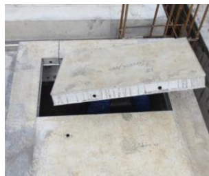
图12 楼面模板安装模板收口
