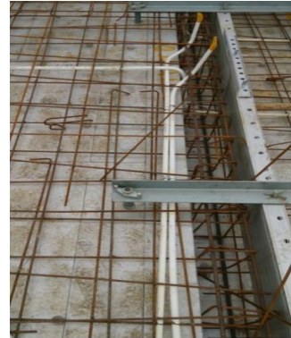
图15 现场铝模吊模、反坎安装示意图
