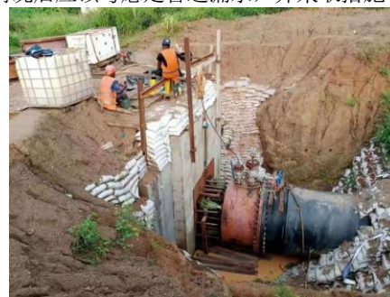
图7 管道注水打压
