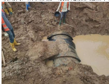
图8 管道漏水
