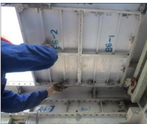
图11 楼面模板安装模板收口
