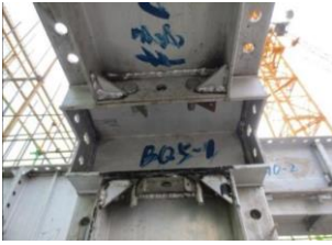
图3 梁底与墙柱模板节点
