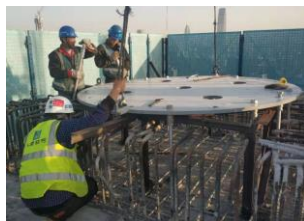
图5 支座连接板及锚栓安装
