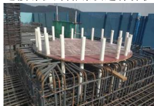
图3 定位模具安装
