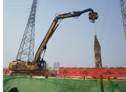
图7 气囊吊装
