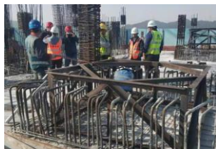
图4 调平固定支架安装
