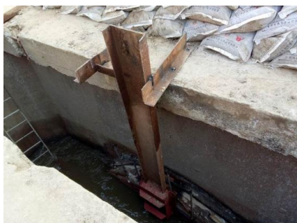
图10 钢挡板固定
