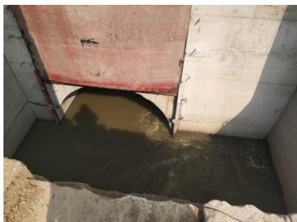
图11 封堵完成后污水改流至超越管
