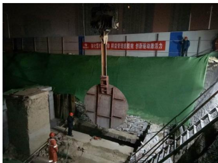
图9 安装钢挡板
