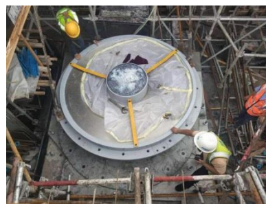
图7 下座板+中座板组合后吊装示意图
