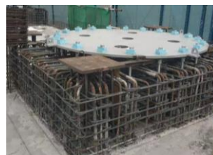
图6 连接螺栓外露螺纹保护
