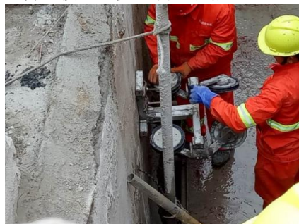
图3 安装导向滑轮
