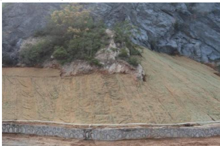
图 9 陕西某矿山植生草毯施工后照片
