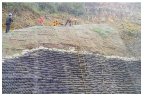
图 10 陕西某矿山植生袋施工现场
