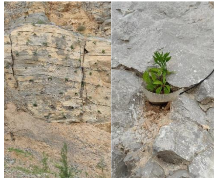
图3 陕西渭南某矿区白茚山打孔点穴法治理后一个月照片
