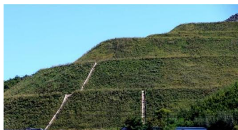
图 12 某高陡边坡台阶治理照片
