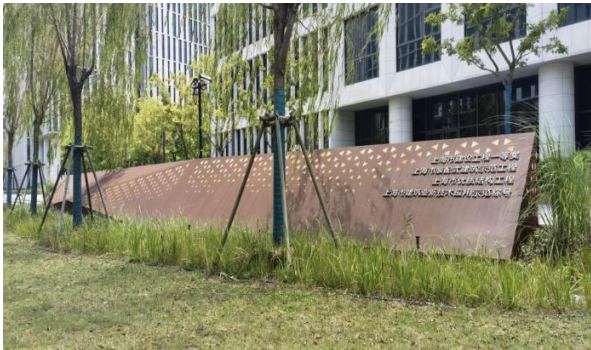
图 1 耐候钢材料景墙使用示例图
