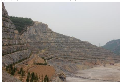
图 11 河北省某高陡边坡坡率法治理照片
