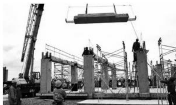
图2 装配式构建安装施工
