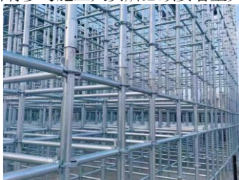
图1 某工程盘扣式脚手架装设示意图
