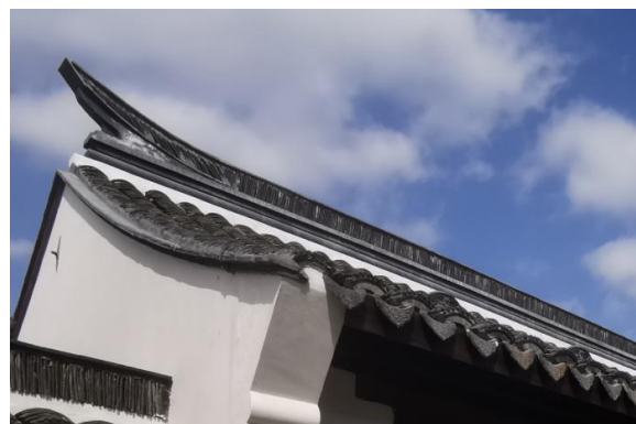
图5 修缮的雌毛脊与滴水瓦当,补充历史建筑装饰细节
