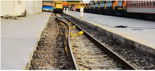
图5 钢轨拨弯现场图
