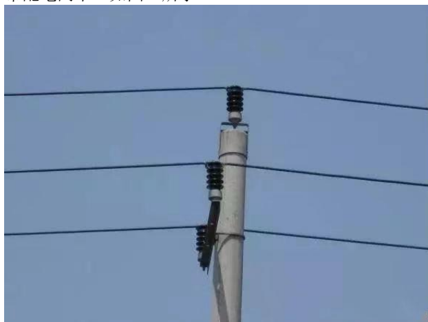
图 3 单回路单柱式绝缘子三角排列杆
