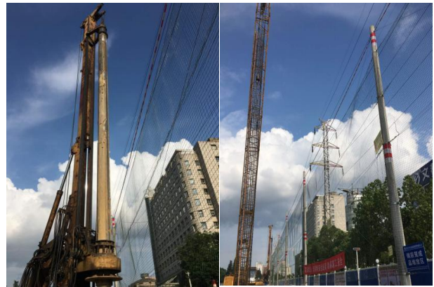
图8 水平限界高压防护系统下钻孔桩施工
