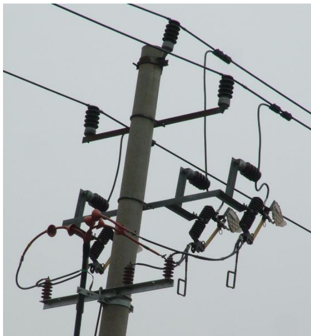
图 1 10kV 避雷器
