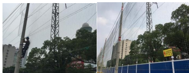
图4 水平限界高压警示钢丝网现场安装
