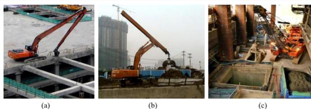
图 14 (a) 长臂反铲; (b) 液压抓斗; (c) 机械抓斗
