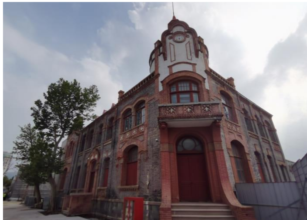
图3 克利顿大饭店旧址（修缮前）
