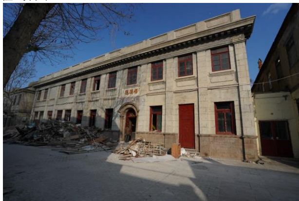
图4 福顺德银号旧址（修缮前）
