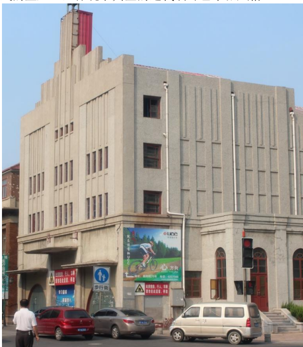
图6 新中国电影院旧址（修缮前）
