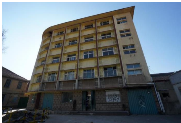
图7 典型1980-1990年代风格建筑（修缮前）
