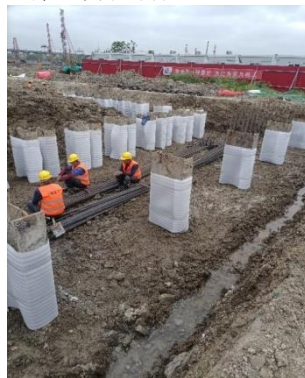
图 2 泡沫塑料包裹隔离
