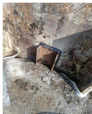
图 3 槽钢卡扣焊接
