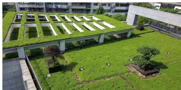
图1 某公共建筑的绿色屋顶
