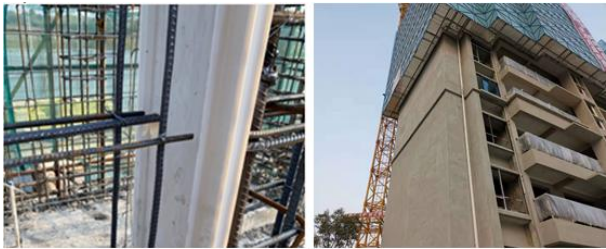
图 2 外墙一次与二次结构竖向拉缝板 外墙穿插施工效果图
