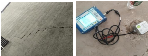
图2 村庄建筑状况及振速监测
