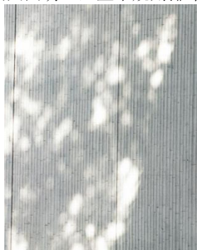
图2 预制装饰清水混凝土
